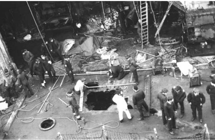
Dstrucción del hangar, helicóptero y boquete en cubierta hangar del HMS Glamorgan .
